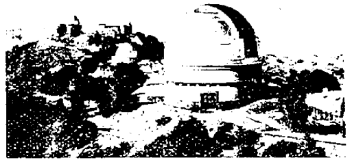
リック天文台遠望、ドームは右 120 呎、中央カーネギー天體寫眞儀、左 36 呎屈折
