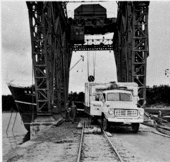
60 トンクレーンによりトラックに積みかえる
