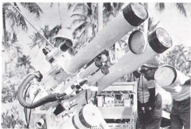
ミネソタ大学ナイ教授のコロナ偏光計 (赤外用と青色光用の二連望遠鏡) 右端に花山天文台の斉藤氏が見える。
