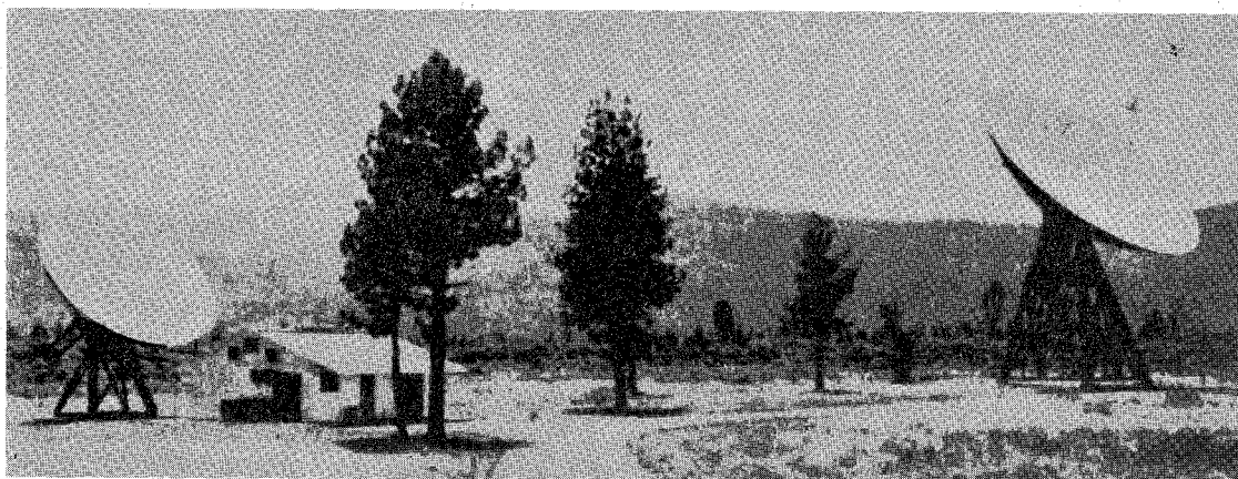
ハットクリークのカリフォルニア大学電波天文学研究所観測所。左が33フィート、右が85フィートの赤道儀式パラボラアンテナ。
