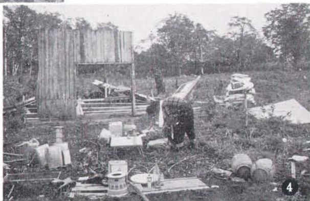
④ 昭和 40 年 9 月 10 日、台風 23 号のために 倒れた大雨見山観測小屋。
