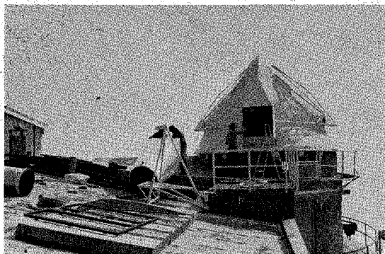
ピック-デュ-ミディ天文台のいわゆる砲塔。 この写真では筒先がはずしてある。
