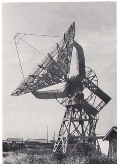
南側からみたアンテナで、極軸を中心に、腕や反射鏡、平衡錘が取付けられている。焦点に見られるものはビックアップ用のアンテナ。
