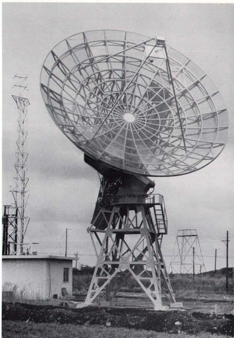
アンテナと観測室の全景。塔体の上部に短い極軸が見える。アンテナの中心部の地上高はほぼ10メートル、東は海で西は平地であるから見通しがよい。
