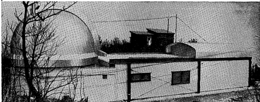
海上保安庁 白浜水路観測所6 m天体観測室ドームとスライディングルーフ
