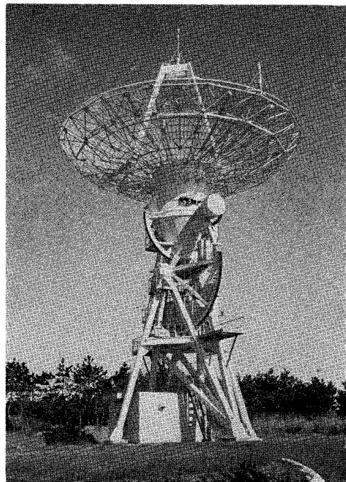
数値制御するときに困難が残る。この点を考慮したマウントの方式がX-Yマウントである。写真でも判るようにX、Y 2軸は、その中央で直角に交叉するので重力の方向に対して重心の位置は不動である。写真で見るとおりパラボラがかさばって大きいこと、人工衛星が速く動くこと等のため非常に大きなギヤを含む両軸のマウントを一軸づつ上方に積み重ねたようになり、結果として背の高い構造となっている。頭部が大きく、随分アンバランスに見えるが、それぞれのギアの内側に充分オモリを取付けて、全体のバランスをとっている。運転中は18mのパラボラが文字通り「サッ」と振回される感じで、追尾用アンテナの高性能を見せつけられた感じであった。両軸のドライブは勿論数値制御になっている。（写真是郵政省電波研究所の川尻義大氏の提供）（赤羽賢司）
