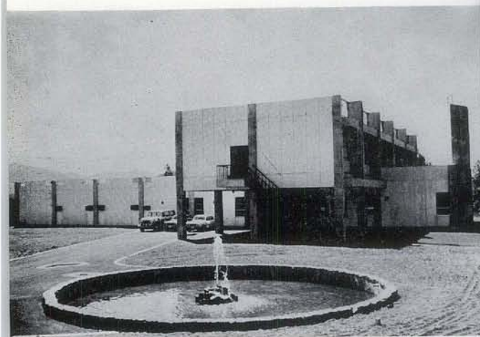
▲ 本館：研究棟，管理棟，宿泊棟を兼ねている。
