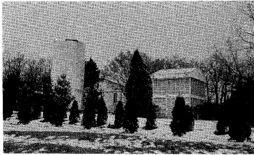
写真 1 65 cm PZT (左). 中央, 右の建物が, PZT 1 号機アストロラープの観測室
