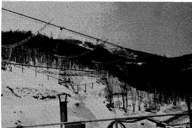
で、フィード部分を地上近くへもってくるとパラボラ先端の地上高は 30 m 以上になる。これは山の北斜面にアンテナが建設されているためである。この菅平のアンテナは両端の反射面枠に手すりと足場がつけられていてパラボラの先端まで歩いて（実際我々は這うようにして歩くのであるが）いくことができステンレス線の保守ができるようになっている。線のたるみを直すのは我々でも恐る恐るできるが、途中切れた線をつないだり、張り直したりするのはもはや鳶職にお願いしなければならない。フィード系の調整も 5 m 高の工事現場用の足場が組んであってその上でおこない、受信機の取りつけ、配線には腰に安全ベルト、足は地下足袋の鳶職スタイルで鉄塔によじのぼるのである。幸い豊川、富士のアンテナは地上高が低いのでこの様な苦労はしなくてよい。
