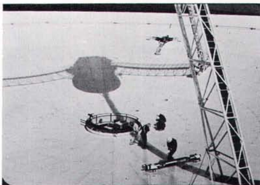
▲ 81年春、パネルをはりおえて鏡面調整に入った45 m 鏡
