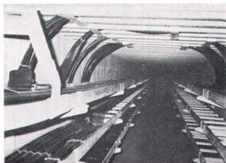
▲ 干渉計の 30 ケ所のステーションは地下のトンネルを通るケーブルで観測棟と結ばれる。
