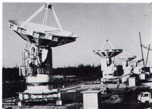
▲ ずらりと並んだ干渉計の10 m 鏡も次々と完成してゆく。
