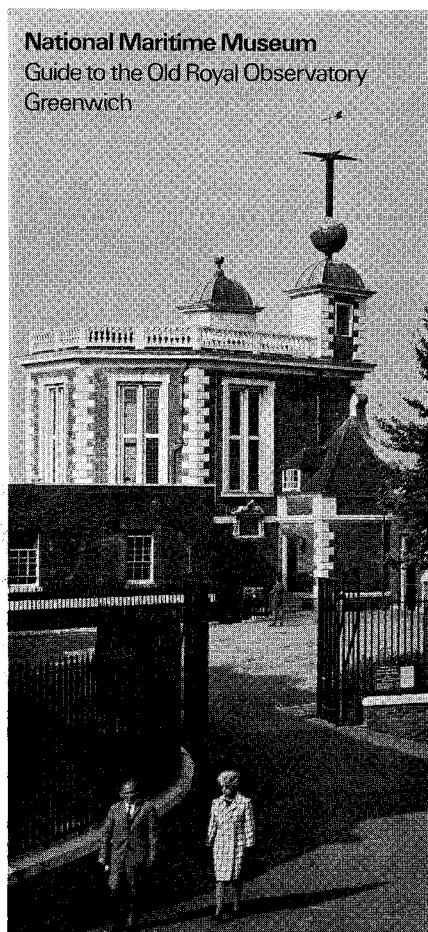
図3 フラムステード館。屋上にグリニッジ報時球がみえる。
