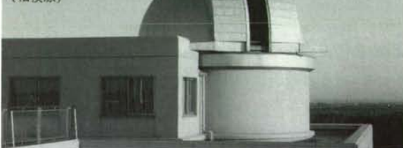
東京葛飾区郷土と天文の博物館 4mサンドーム(90°回転、ドア180°回転解放型)
