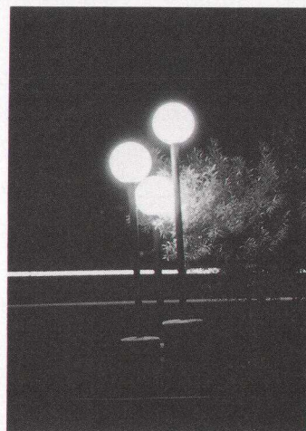
図4 図3の照明器具を夜に点灯すると、半分近い光が上方に逃げて無駄になっている。しかし、照明器具の真下には光は届かない。(国際暗夜協会 IDA 提供)。
