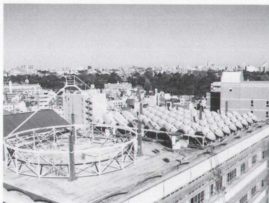
写真：64 素子干渉計と建設中の 15m 固定球面鏡
