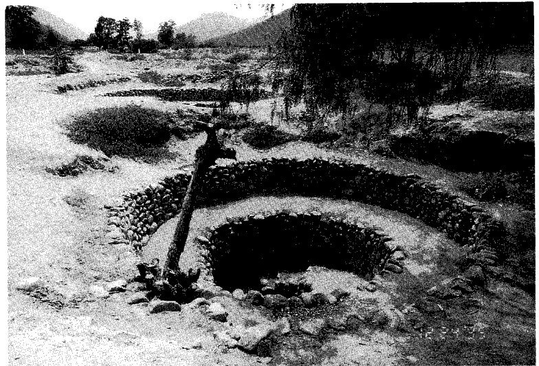
図6 ナスカの灌溉施設 渦巻き井戸の列が地下水道に沿って続く
