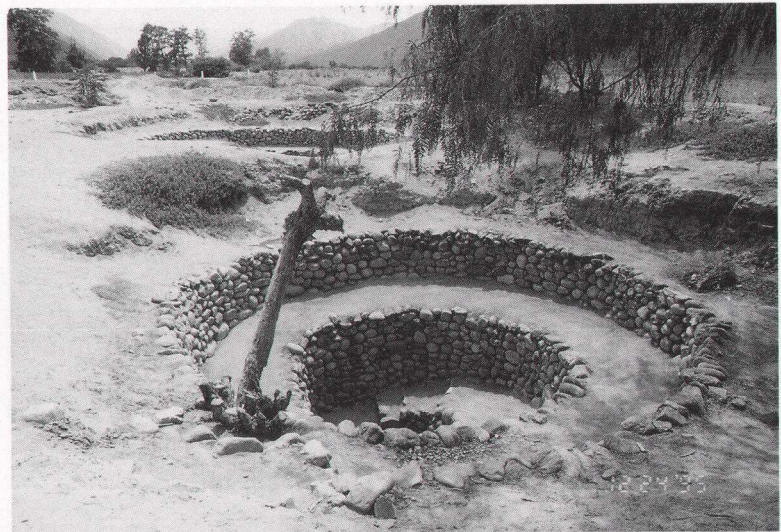
図6 ナスカの灌漑施設 渦巻き井戸の列が地下水道に沿って続く
