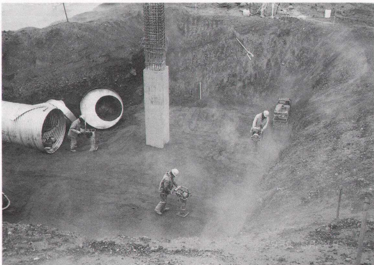
写真1 制御棟のコンパクション作業中のワーカー
