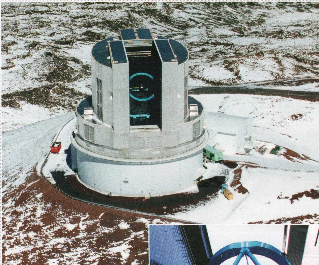
写真1 雪景色のすばる望遠鏡ドーム（空撮写真）。スリット開口部からすばる望遠鏡のトップリングが見える。 （撮影／宮下暁彦）
