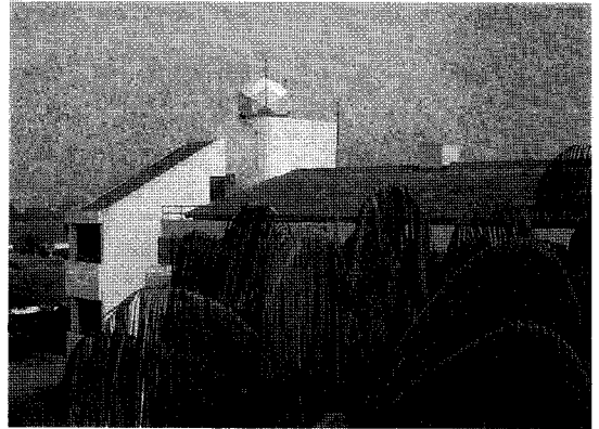
写真 2. 国立シンガポール大学理学部屋上に設置された HETE-2 主地上局。レドームの中には、直径 1.8 メートルの S バンドパラボラアンテナがある。
