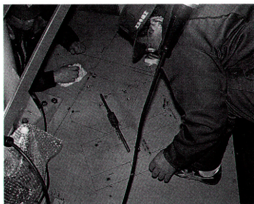
図4: HIDES 定盤上に書き込まれた罫書き線。細い正 確な線の上に、分かりやすいように太い線が重ね 書きしてある。指定位置に穴を開けタップを立て ているところ。
