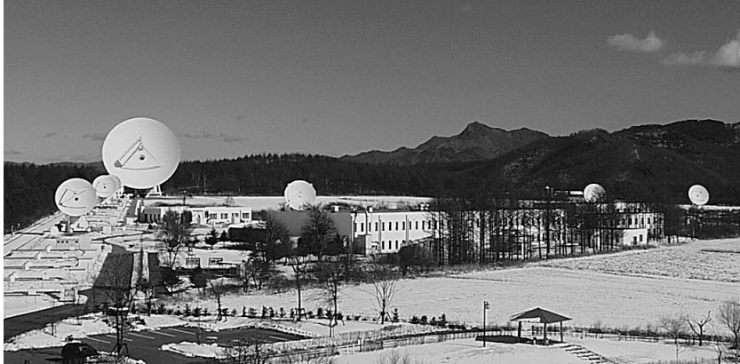
図2 野辺山レインボー干渉計の全景（国立天文台提供）。手前に見える6基の10mアンテナ群が野辺山ミリ波干渉計，左手奥に見えるひときわ大きいパラボラが45m電波望遠鏡。野辺山宇宙電波観測所は，1年間で最も気象条件が良い1-2月の2週間程度の期間をレインボー干渉計セッションに当ててきました。
