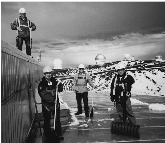
写真 1 「すばる」のドーム屋上での除雪作業。
