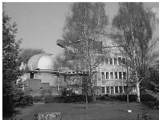
図8 デブレツェン太陽物理観測所の外観。
