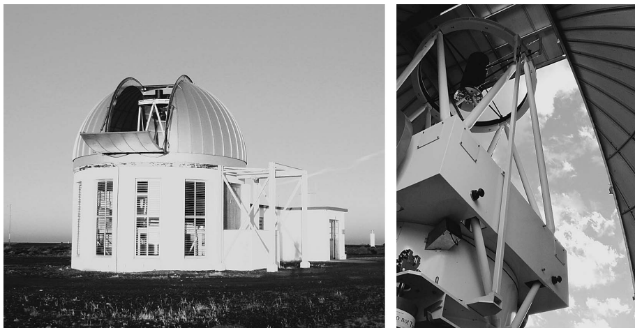
図2 南アフリカで運用中の IRSF 望遠鏡 (右) と、望遠鏡のドーム (左)。ドームの横には望遠鏡操作室がある。IRSF チームによる自動化システムの整備により観測初心者が単独で運用することも可能になっている (写真クレジット: 国立天文台・名古屋大学)。
