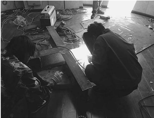
図4 ドームピアーに赤道儀を設置するためにピアーにインターフェイスを溶接作業しているところ。
