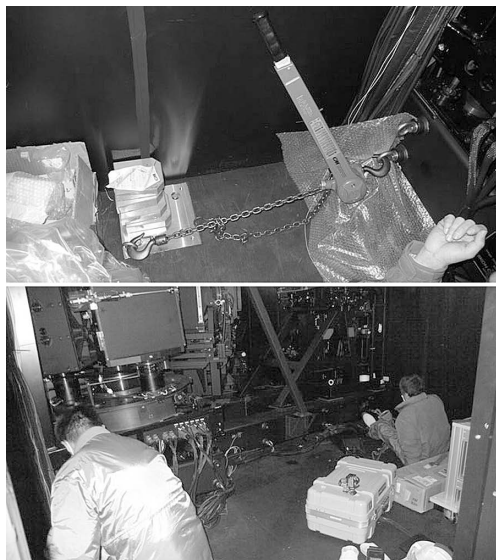
図2 2006年12月の復旧作業にてHDSのユニット全体（総重量約6トン）をチェーンブロック（上）を使って人力で2mm水平移動させる。下写真は右から宮野英治氏，小室俊氏（株式会社ニコン）。
