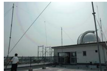
図3 屋上に設置したアンテナ
