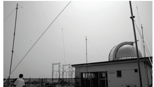
図2 本校屋上に設置したダイポールアンテナ
