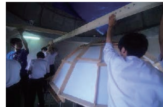
[図3]製作中の様子
