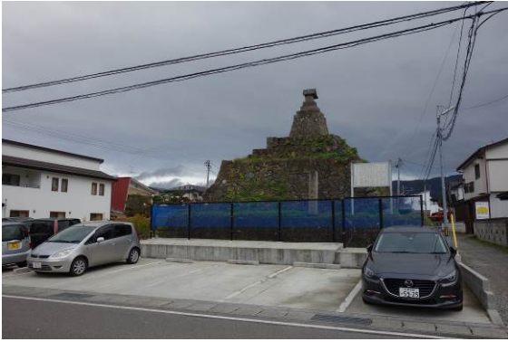
天文台西側（台上の祠は天文台とは無関係） 向かって左側（北側）が取り壊されている。 以下いずれも2018年11月19日撮影
