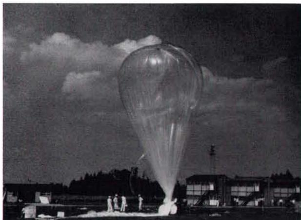
8月27日14時46分、福島県原町市の東京大学大気球実験場から、東大宇宙航空研究所の「軽量気球開発スケジュール」の中の最大の気球が放球された。気球容積は $30000\text{ m}^3$ で、毎分220mの速度で上昇し高度32kmに達して水平浮遊状態になった。21時46分指令電波により観測器を気球より切離し、パラシュートで福島県川俣町付近に降下させた。
