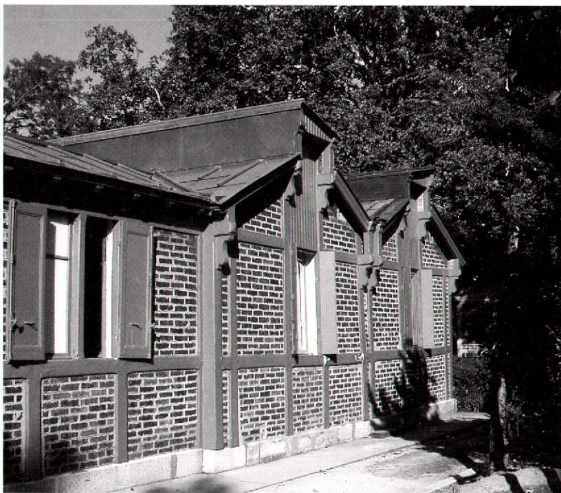
図2. 旧モンスウリ天文台の二連子午儀小屋（モンスウリ公園内）。特徴のある屋根の尖りが、かつて2台の子午儀を納めていたことを窺わせる。
