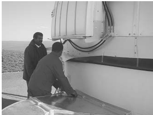
ドームを修理してくれているSAAOスタッフ。
