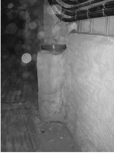
写真8 深い水抜き用井戸.
