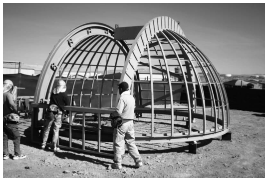
図2 カラマの町で組み立て中のドーム。
