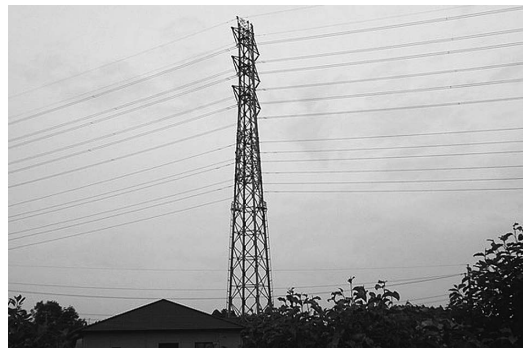
図3 観測所東側の高圧線鉄塔。
