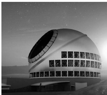
図4 風抵抗の少ないカーセル型TMTドームの完成予想図。
