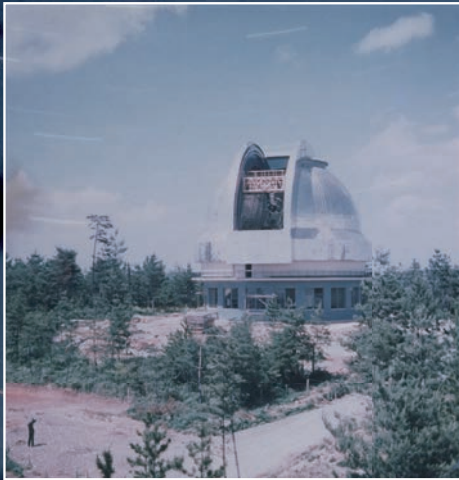
図3 188 cm 望遠鏡の据え付け作業を終えた頃のドーム（1960年）。
