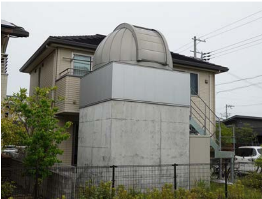
図1 自宅の観測室 敷地内に3 m ドームを設置。望遠鏡ピラーの地上高は3 m。
