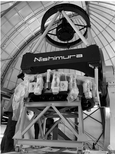
建設途中のPRIME望遠鏡。主鏡をマウントしているところ。望遠鏡上部の主焦点部にレンズ光学系とカメラがマウントされる。
