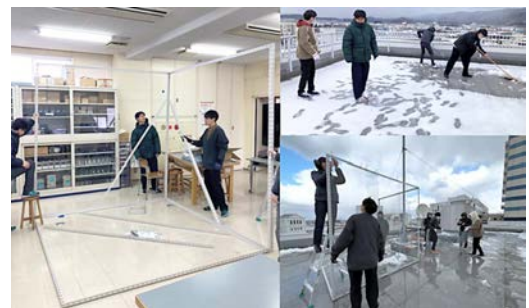
図2 (左) 屋内での3DCR仮組みの様子、(右) 屋上での3DCR組み立ての様子。
