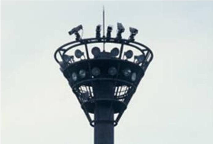
東名高速道路、足柄サービスエリアの投光器照明。投光器の設置角度が鉛直角 70 度から 80 度。漏れ光の量は、メーカーのデータから 17% から 29% と大きい。これは光害対策ガイドラインに示される「あんしんの街路照明」照明環境 I に適用される上方光束比ゼロ% を大きく超える値であり、箱根足柄および富士山周辺の自然の豊かで暗い空の残る環境の光害の原因となる。
