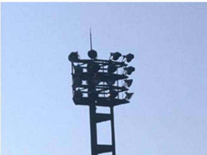
東名高速道路、横浜町田料金所の投光器照明の設置状況。同様に投光器の設置角度が鉛直角 60 度から 65 度に取り付けられており、漏れ光の量は、メーカーのデータから約 10% と大きい。
