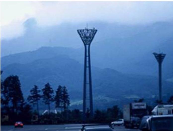
東名高速道路、中井パーキングエリアの投光器照明の設置状況。足柄サービスエリアと同様投光器の設置角度が鉛直角 70 度から 80 度に取り付けられており、漏れ光の量は、メーカーのデータから 17% から 29% と大きい。
