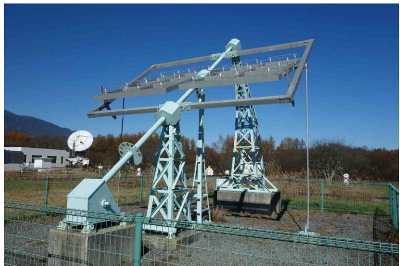
図2. 三鷹200MHz太陽電波望遠鏡の現在の設置状況
